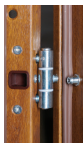
bezpečnostný pánt a hrot proti vypáčeniu
